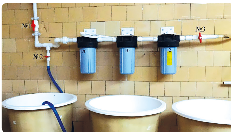
Рисунок 50. Механические фильтры для очистки морской воды и баки для выращивания личинок устриц (питомник ФИЦ ИнБЮМ)
