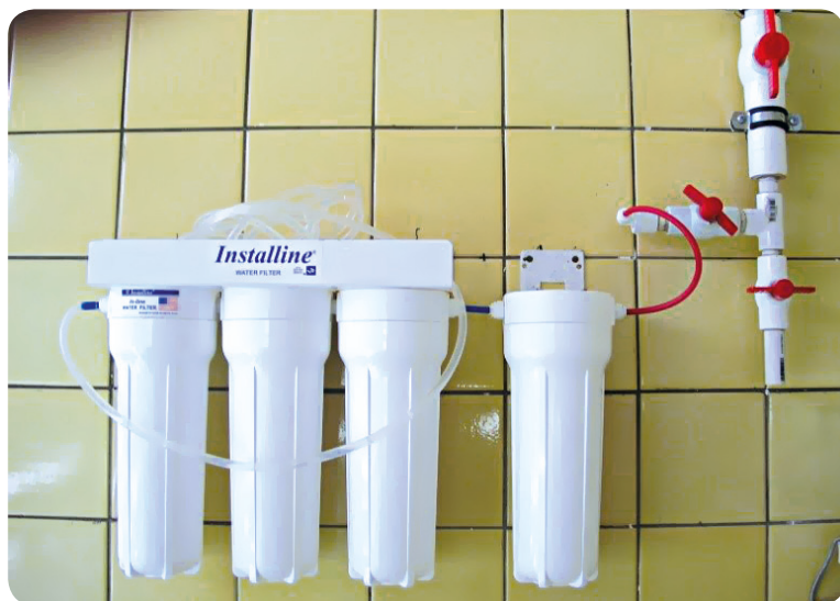
Рисунок 26. Установка для очистки морской воды в питомнике ФИЦ ИнБЮМ
